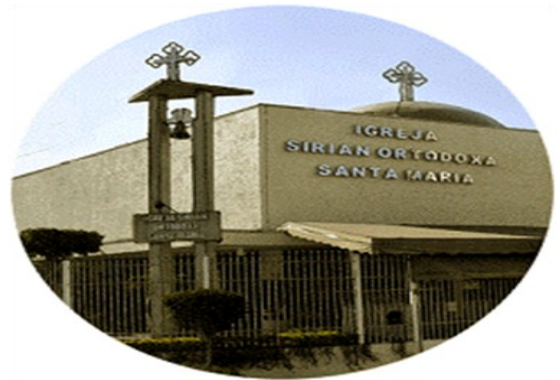
Igreja Santa Maria – em São Paulo - Brasil (construída em 1981)
